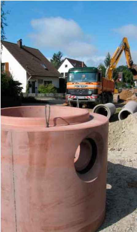
Perfect-Schacht bereit für den Einsatz im „Baulos Erschließung Baugebiet Hauptstraße/Marchstraße“
