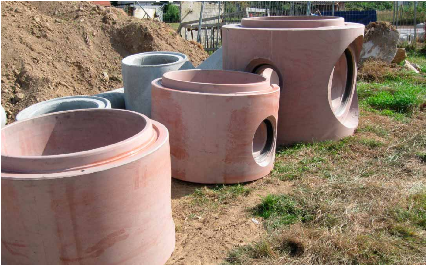
Schachtunterteile aus HL-Beton werden in Denzlingen in den Nennweiten DN1000 und 1200 eingesetzt
