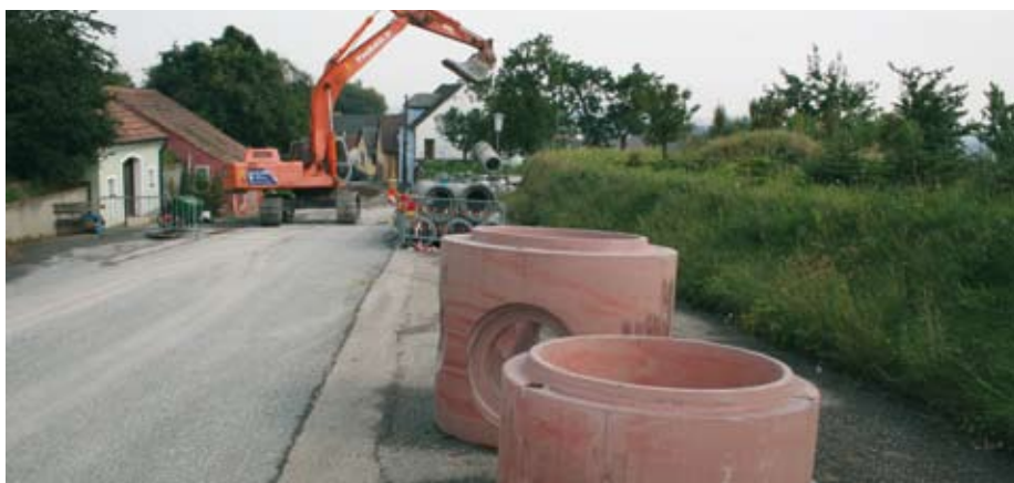
Maßgefertigte Betonkammerböden aus HL-Beton C60/75 im Einsatz im Traisental
