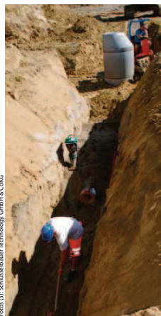
Neben der chemischen und statischen Eignung zeichnet sich das neue Rohrsystem auch durch die einfache Verlegung und entsprechend hohe Einbau-Leistungen aus.
